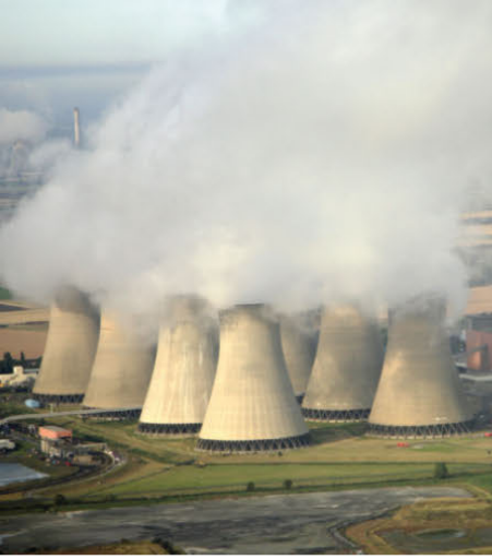
الشكل ٨ تستخدم محطة توليد الكهرباء أبراج التبريد لخفض درجة حرارة الماء الحار الناتج عنها.
