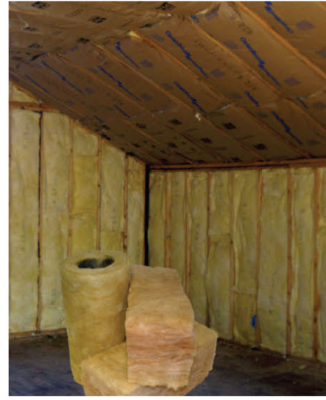
الشكل ٧ تعمل المواد العازلة في المنازل والبنيات على تقليل من انتقال الطاقة الحرارية بين الهواء داخل المنزل والهواء خارجه.
