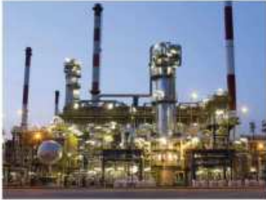
محطة توليد الكهرباء في الجبيل
